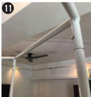
11. 上部フレームを取付けます。3分割された上部フレームの1つを先ほど組み立てたロッド6本のうちの2本に差し込みます。同様の作業を繰り返し上部フレームを組み立ててください。
