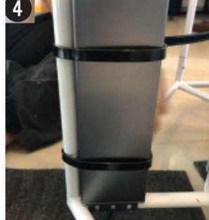
4. 固定位置が決まった後に結束バンドを締め付けて固定します。
